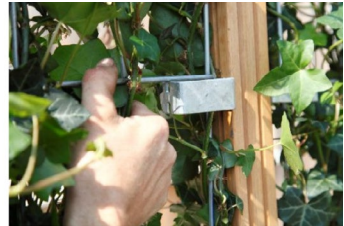
8 De haag kan "gehangen" worden in de uitsparing van de bovenste beugels.
