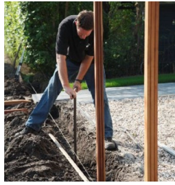
3 Plaats de palen op een afstand van ca. 125 cm (max 130 cm).
