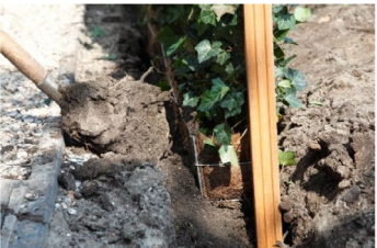
10 De plantsleuf wordt aangevuld met uitgegraven grond incl. bodemverbetering. Let op: bovenzijde verteerbare bak is gelijk aan het maaiveld.
