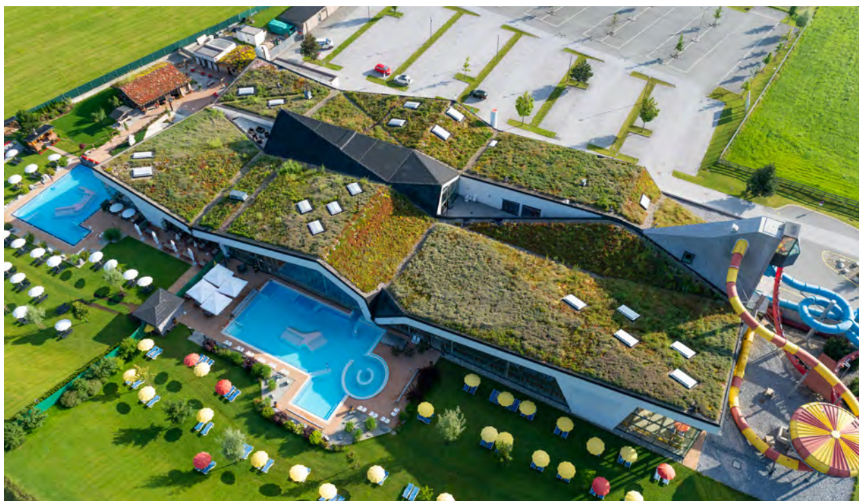
Abb. 22: Das Siegerobjekt aus einer anderen Perspektive fotografiert: Herausforderung durch unterschiedliche Dachneigungen. Quelle: Bauder
