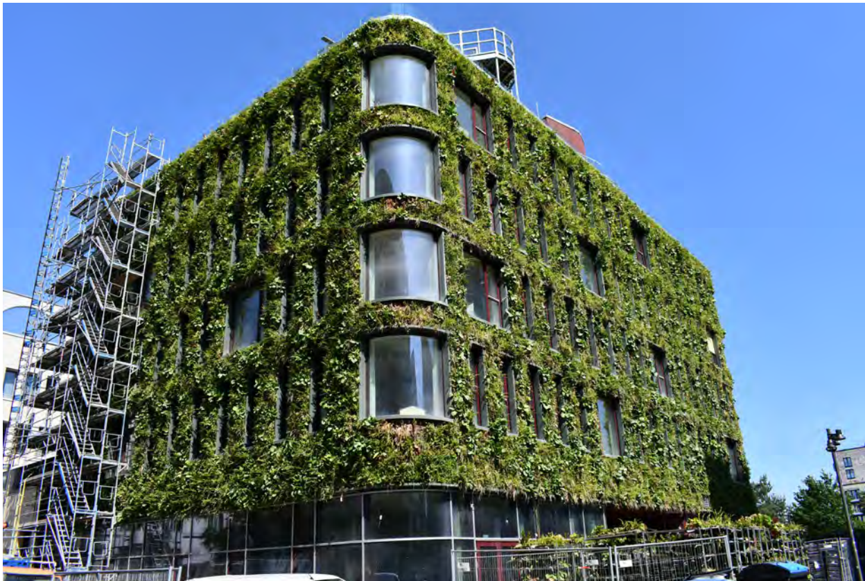
Abb. 64: Bei den wandgebundenen Fassadenbegrünungen gab es in 2024 ähnliche Flächen wie in 2023. Quelle: BuGG
