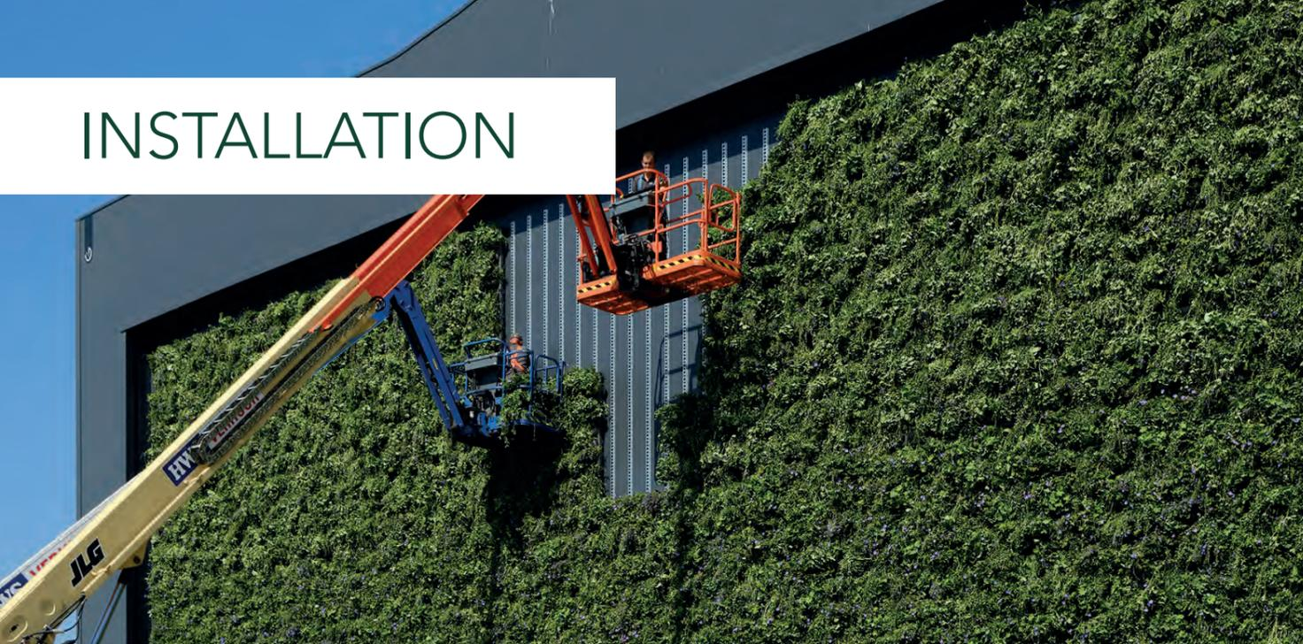
Für das Fassadenbegrünungssystem MobiPanel wird eine automatische Bewässerung mittels einer Bewässerungsanlage empfohlen, da der Wasserverbrauch je nach Jahreszeit, Klima und Art der Pflanzen variieren kann. Der maximale Wasserverbrauch beträgt in heißen Perioden ca. 4 Liter pro m<sup>2</sup> pro Tag. Mobilane empfiehlt den Abschluss eines Wartungsvertrages mit dem ausführenden Betrieb über Technik und Pflanzen.
