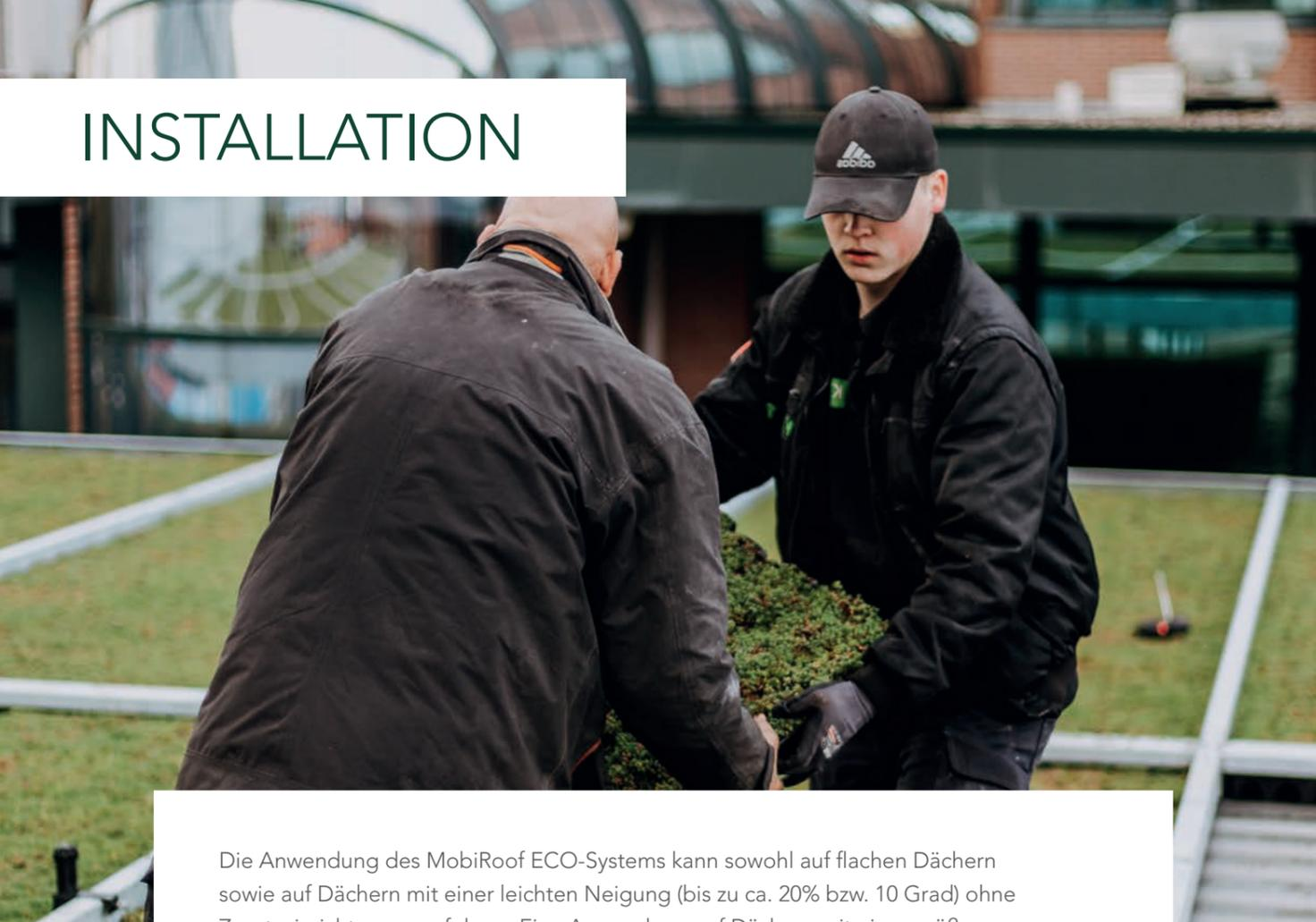
Die Anwendung des MobiRoof ECO-Systems kann sowohl auf flachen Dächern sowie auf Dächern mit einer leichten Neigung (bis zu ca. 20% bzw. 10 Grad) ohne Zusatzeinrichtungen erfolgen. Eine Anwendung auf Dächern mit einer größeren Schräge ist möglich. In solchen Fällen sollte eine Sicherung angebracht werden, zum Beispiel ein L-Profil. Außenseiten 50 x 50 x 6 cm (= 0,25 m<sup>2</sup>). Der Bedarf für 1 m<sup>2</sup> Dachbegrünung liegt bei 4 Kassetten.
