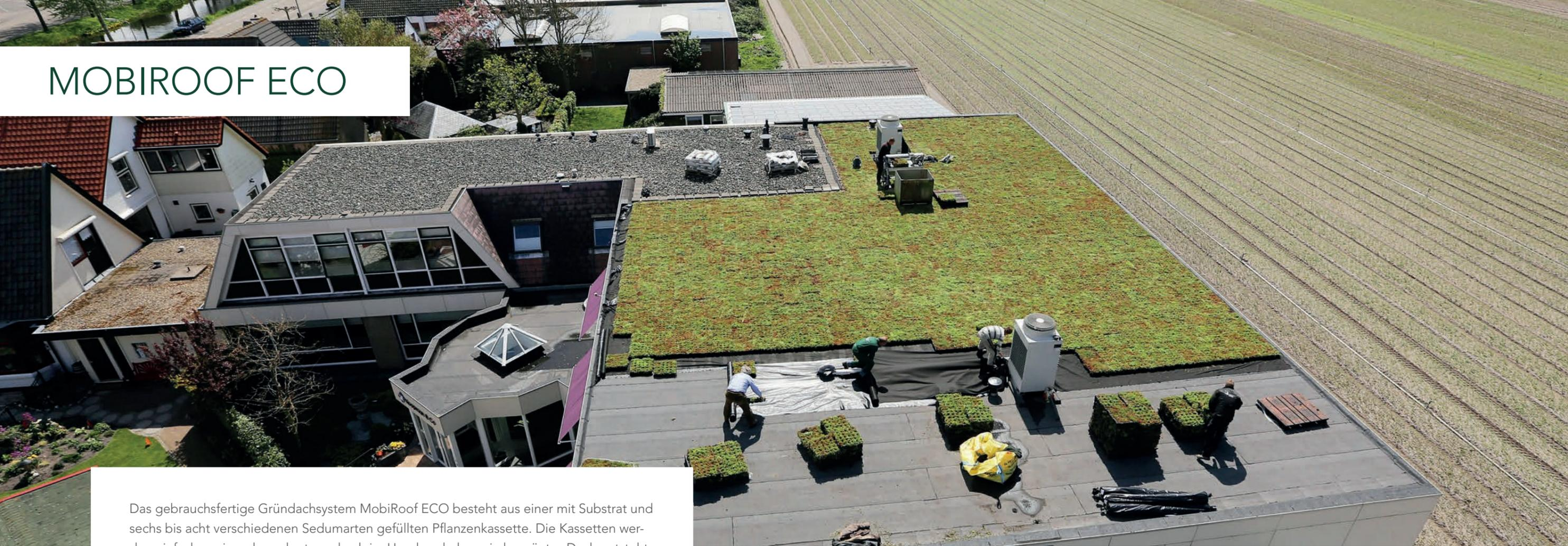
Das gebrauchsfertige Gründachsystem MobiRoof ECO besteht aus einer mit Substrat und sechs bis acht verschiedenen Sedumarten gefüllten Pflanzenkassette. Die Kassetten werden einfach aneinander gelegt, wodurch im Handumdrehen ein begrüntes Dach entsteht. MobiRoof ECO eignet sich für Flachdächer und Dächer mit einer Neigung von bis zu 10 Grad (20 %) und bleibt immer wieder neu positionierbar.
