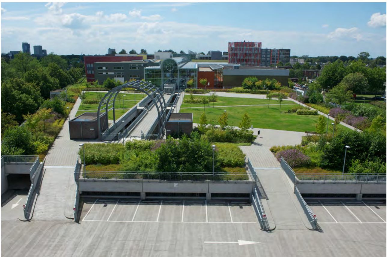
Figuur 15: Een beloopbaar groendak beschermt de dakbedekking.
